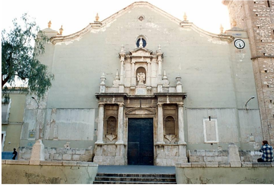
Lápida ubicada en la fachada de la Parroquia de San Miguel, en la parte derecha
