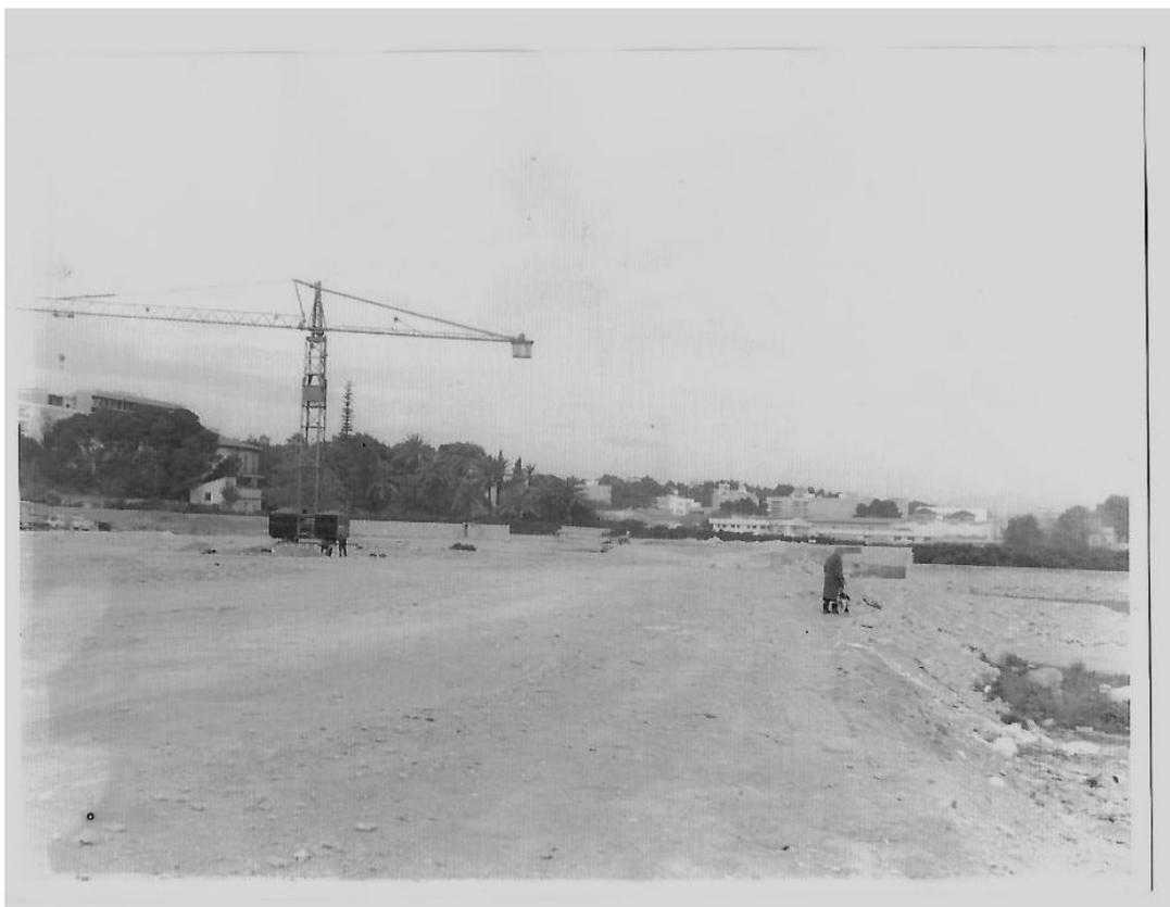
4) Fotografía del terraplenado y explanación del solar del Huerto de Aznar para la construcción del nuevo centro escolar, con la grúa ya instalada. A nuestra izquierda aparecen los chalets de Aznar, y el del Pilar con sus jardines. Fotografía tomada el 22 de enero de 1973 por el fotógrafo y reportero del "Estudio-Cine-Reportajes Alonso" Vicente L. Alonso Doménech.
