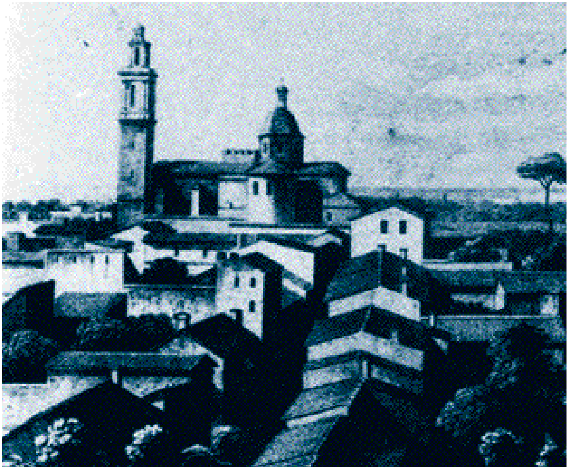
Por detrás de la iglesia se puede observar la torre del Colegio Mayor San Juan de Ribera.
