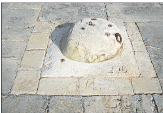
«Pílo» con la numeración por la que se denomina cada silo. T. R.
